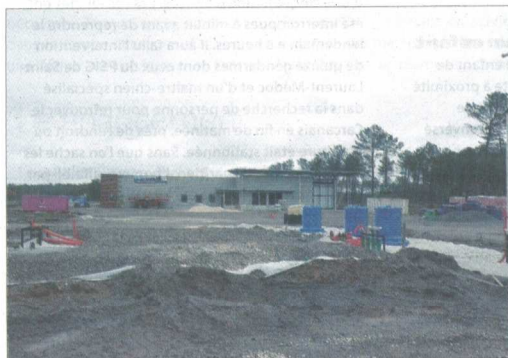
Le chantier en cours à l'entrée du village.
